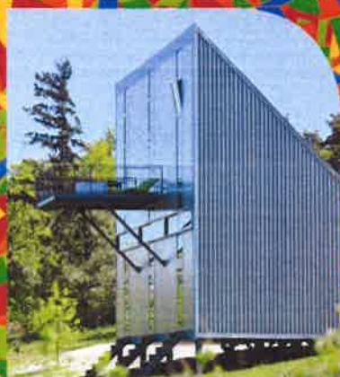
Architectes BARRÉS-COQUET Maison à Saint-Alban-d'Ay, utilisant intégralement la filière sèche
